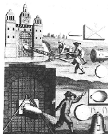
vers une porte ou un mur, de l'y fixer, d'allumer l'engin, en espérant qu'il ne leur explose pas à la figure, puis de s'enfuir à toutes jambes, de préférence hors de la trajectoire opposée au souffle, et tout ceci sous le feu de l'assiégé. Avec un peu de chance, l'explosion pratiquait un trou permettant aux troupes d'assaut d'entrer dans la forteresse. La technique du pétard était assez peu utilisée compte tenu du taux de mortalité élevé chez les pétardiers !
